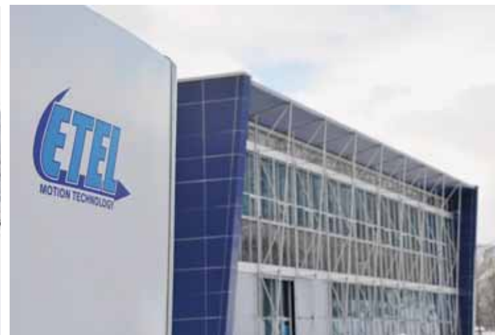
Etel souhaite continuer à se développer à Môtiers. L'entreprise veut acquérir 10 000 m 2 de terrain, qui devraient être trouvés en démantelant les abattoirs et la pisciculture. PHOTOS RICHARD LEUENBERGER
