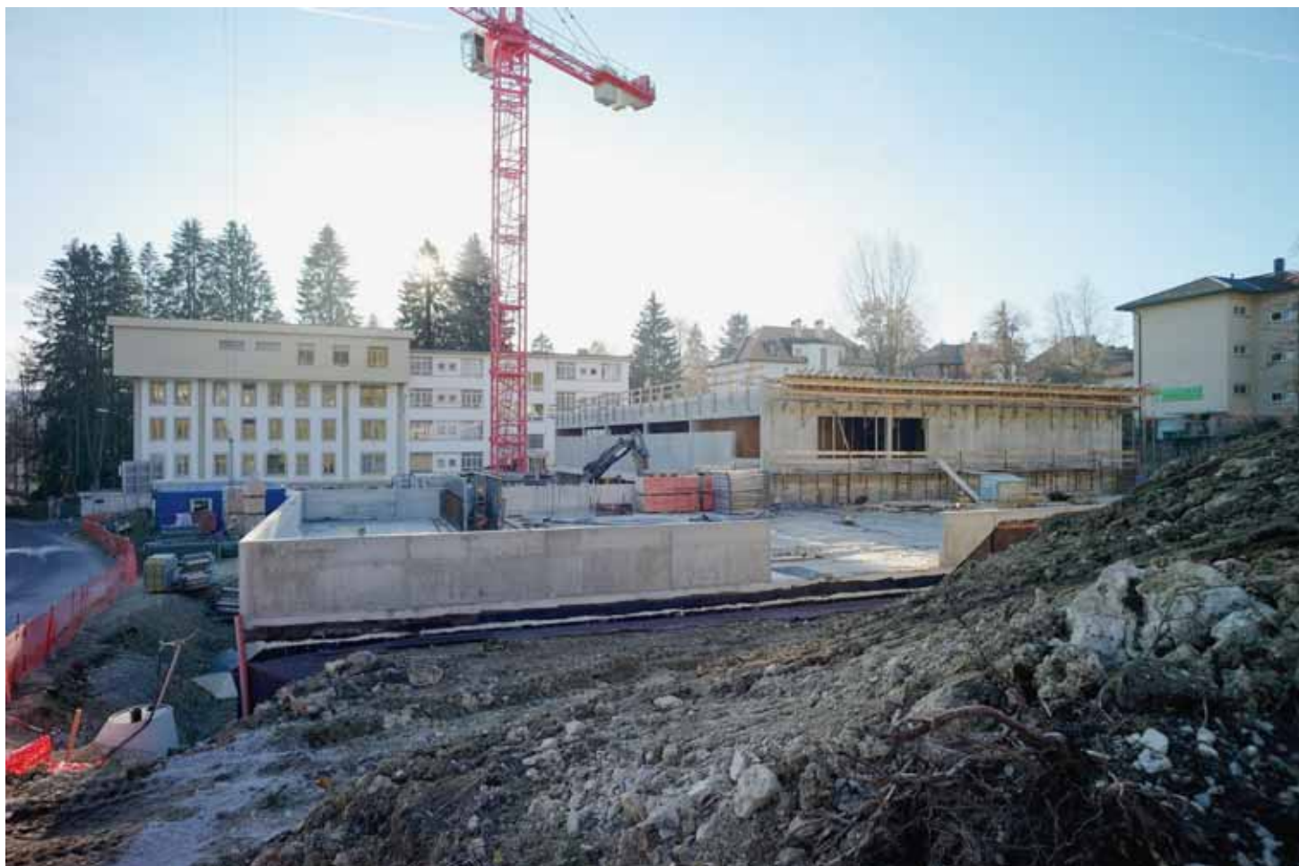
Le nouveau bloc en construction de la clinique Montbrillant sera opérationnel en automne 2012. CHRISTIAN GALLEY
