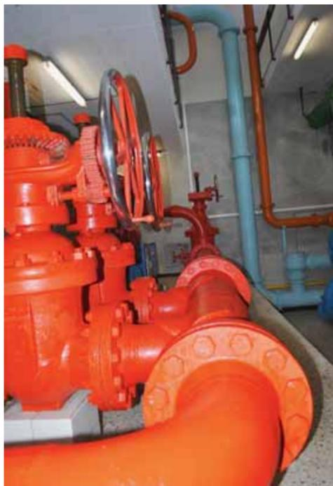
La conduite principale qui chasse près de 5000 l/min d'eau potable jusqu'au réservoir du Mont-Crosin.
