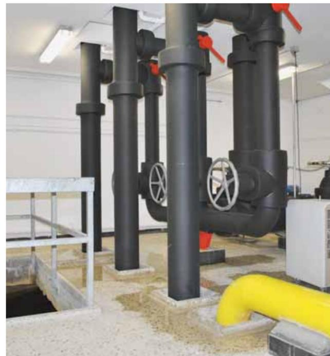
A gauche, le puits de captage de la source, et les tuyaux qui envoient l'eau dans un bassin de décantation et de traitement chloré. YVES-ANDRÉ DONZÉ
