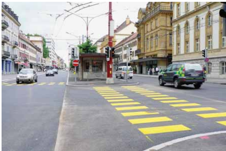
Les deux artères du Pod ont été rouvertes hier.
