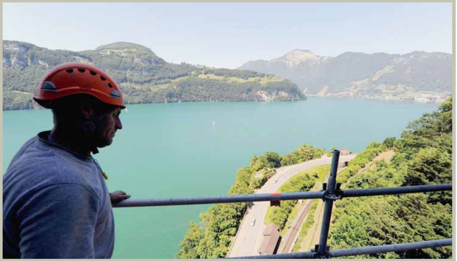
Au-dessus du lac des Quatre-Cantons, dans le canton de Schwytz, on consolide la roche. KEYSTONE
