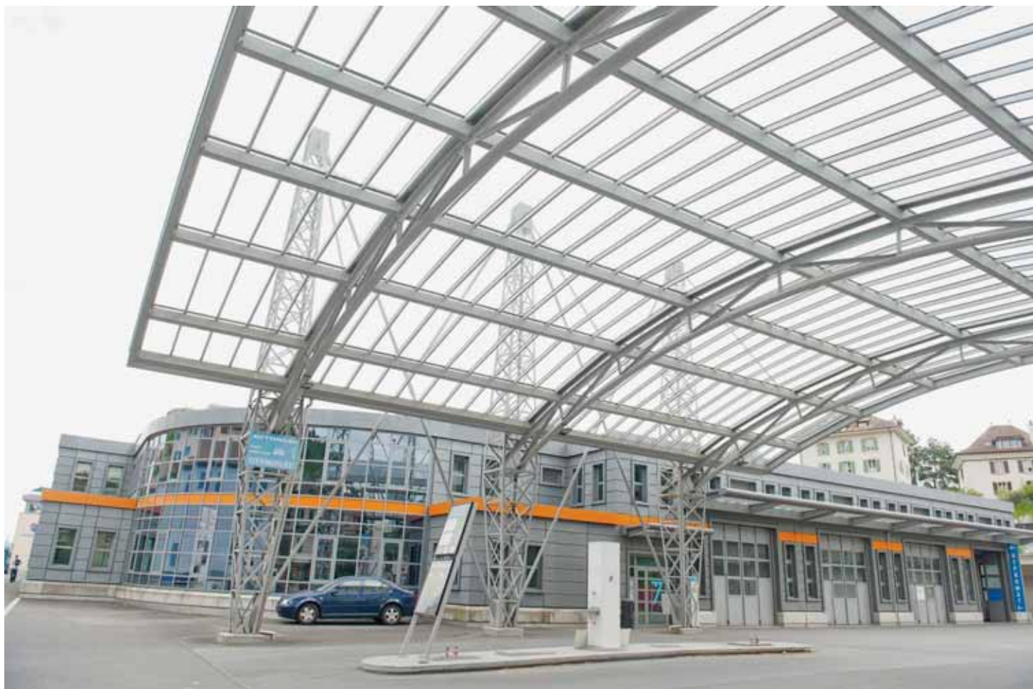
L'ancien garage de la Poste, au numéro 7 de la rue des Draizes, à Neuchâtel, devrait accueillir le premier supermarché Aldi du canton d'ici une année, le temps d'effectuer les travaux de transformation. DAVID MARCHON
