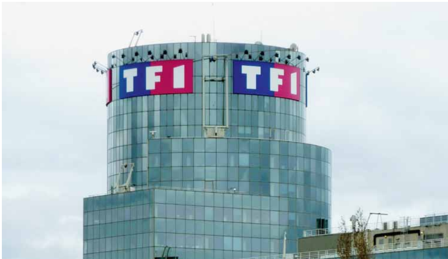
Le siège de TF1 à Boulogne près de Paris. La chaîne est le vaisseau amiral d'un groupe télévisuel puissant. KEYSTONE
