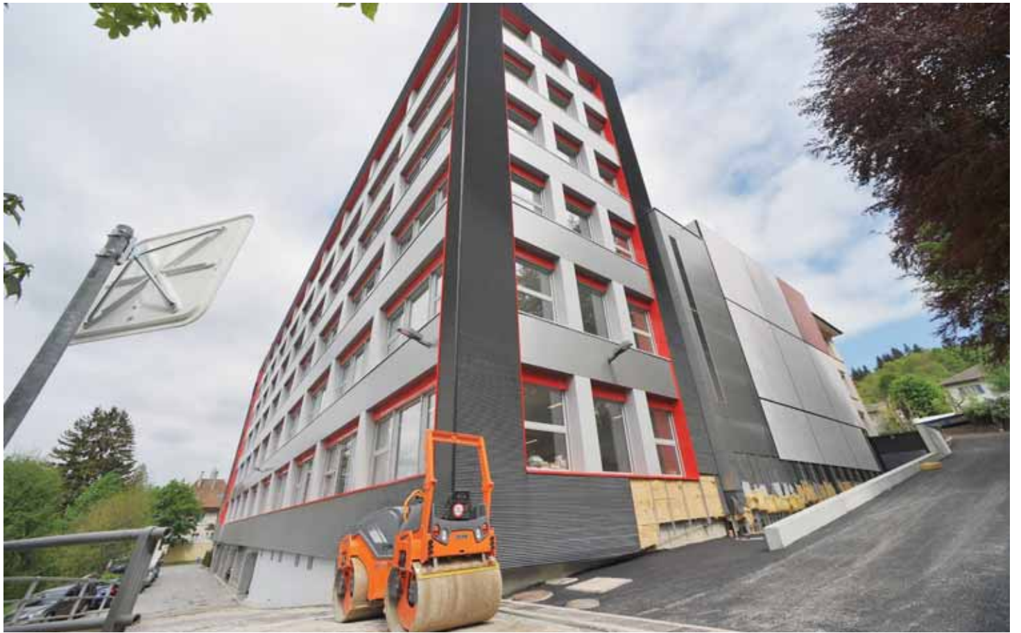
Le centre de logistique fait 400 mètres carrés de surface pour 16 mètres de haut. Il peut recevoir 5 à 6 millions de pièces. CHRISTIAN GALLEY
