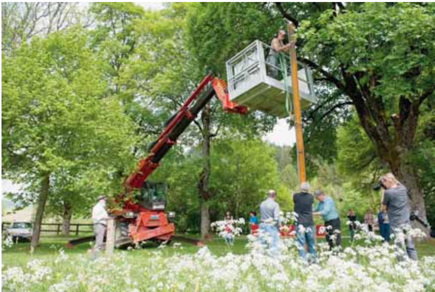
Un manitou a été mobilisé pour dresser la poutre d'acier de 300 kilos.
