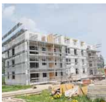
Nouvel immeuble en construction à la Pinsonnière. [DELPHINE WILLEMIN]
