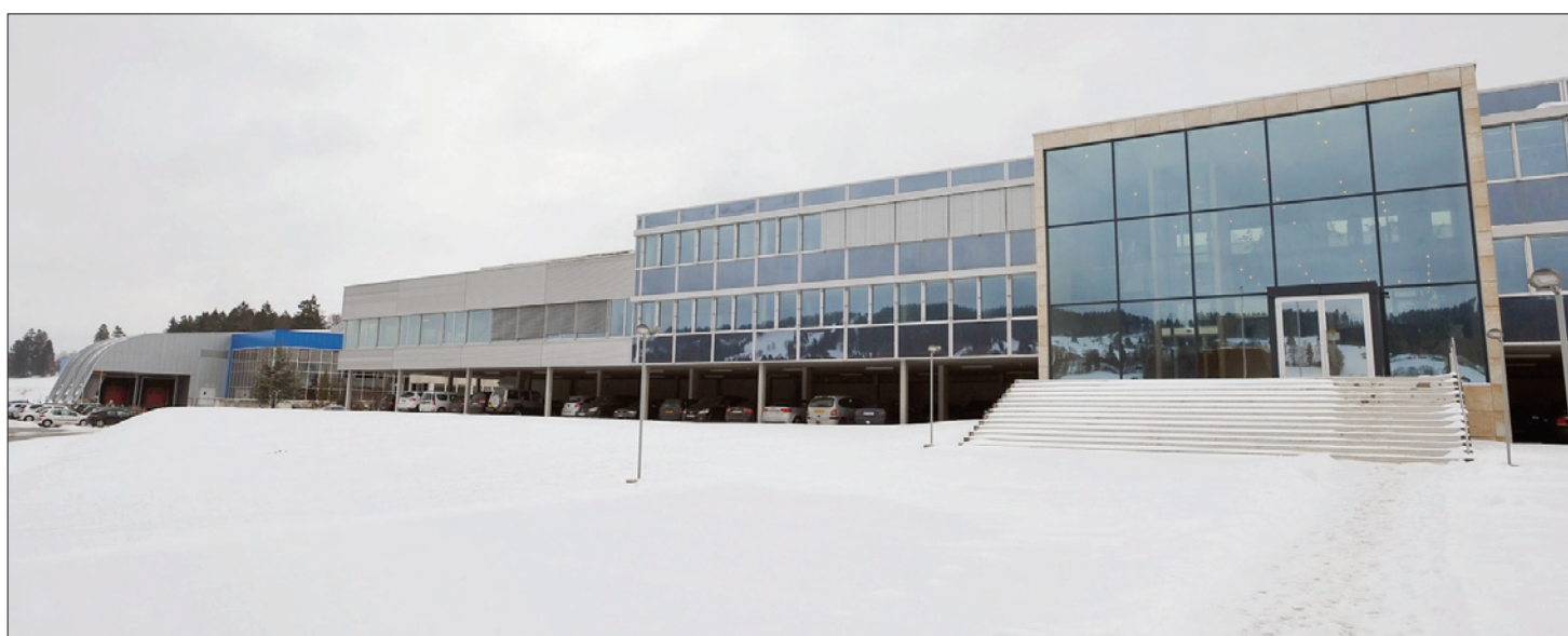
G & F CHÂTELAIN Sise rue du Laser, dans la zone industrielle de La Chaux-de-Fonds, l'entreprise occupe des locaux totalisant déjà 8000 mètres carrés. Elle commence à être à l'étroit et prévoit de s'agrandir pour accueillir le personnel supplémentaire. (RICHARD LEUENBERGER)
