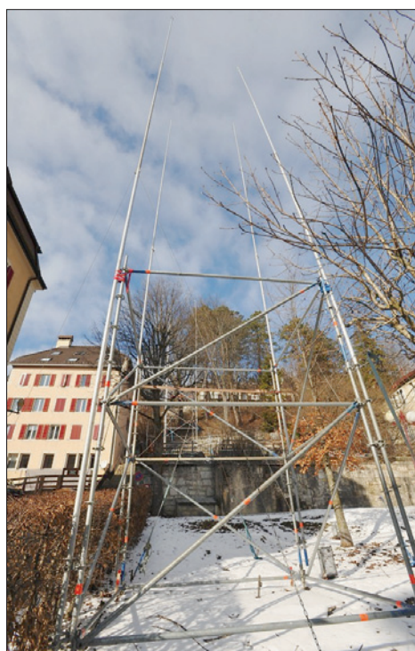
PLACE DU 1ER-AOÛT Les gabarits pour la construction du double ascenseur reliant la gare sont posés. (RICHARD LEUENBERGER)
