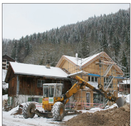
MAISON-BIAUFOND Un nouveau lieu d'accueil est en construction.
