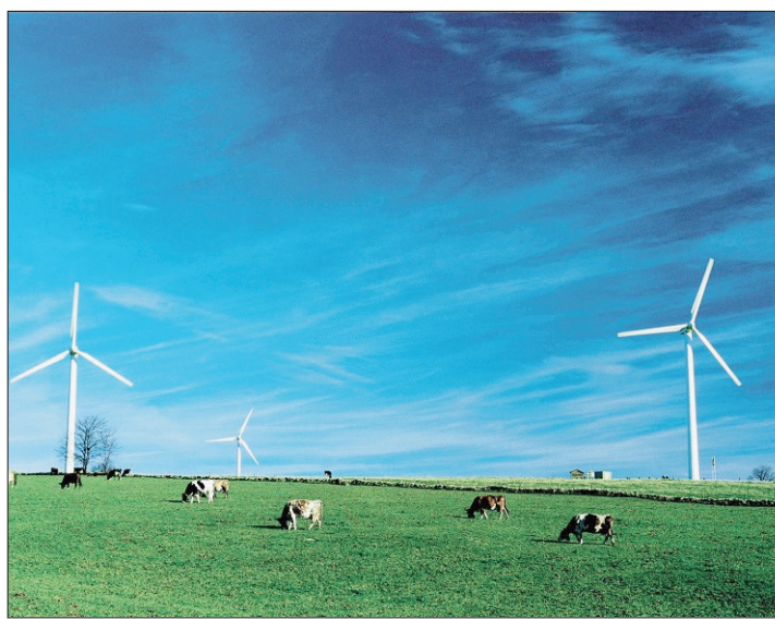
MONT-CROSSIN Les travaux d'extension viennent de commencer sur le site de la plus importante centrale éolienne suisse. (SP)
