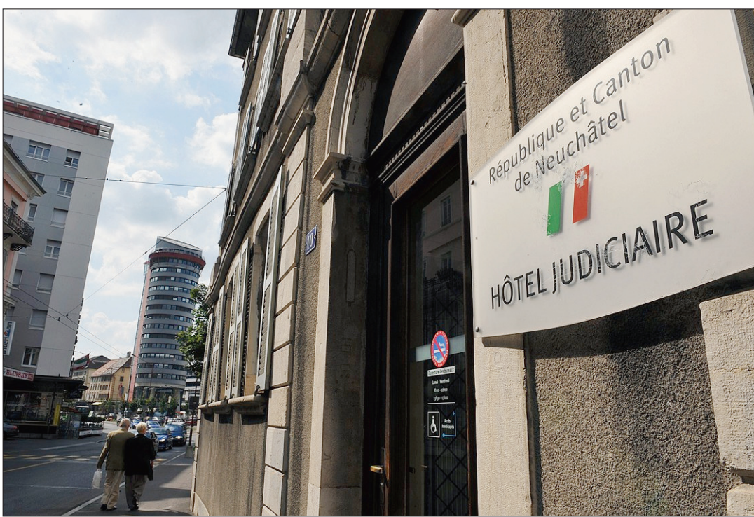
LA CHAUX-DE-FONDS Un nouveau bâtiment devrait être construit pour accueillir un tribunal unique de première instance pour tout le canton. Il serait disponible en 2014. (CHRISTIAN GALLEY)
