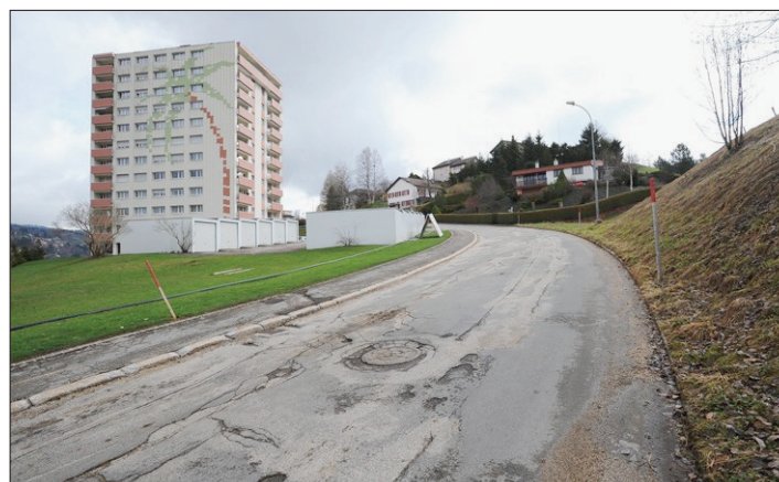
LE CORBUSIER Le tronçon en travaux sera mis en bordiers autorisés. Le cheminement piétonnier est garanti. (RICHARD LEUENBERGER)
