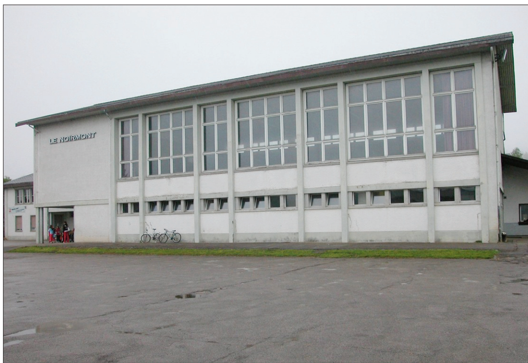
LA HALLE DE GYMNASTIQUE Construite en 1967, elle a fait son temps.
