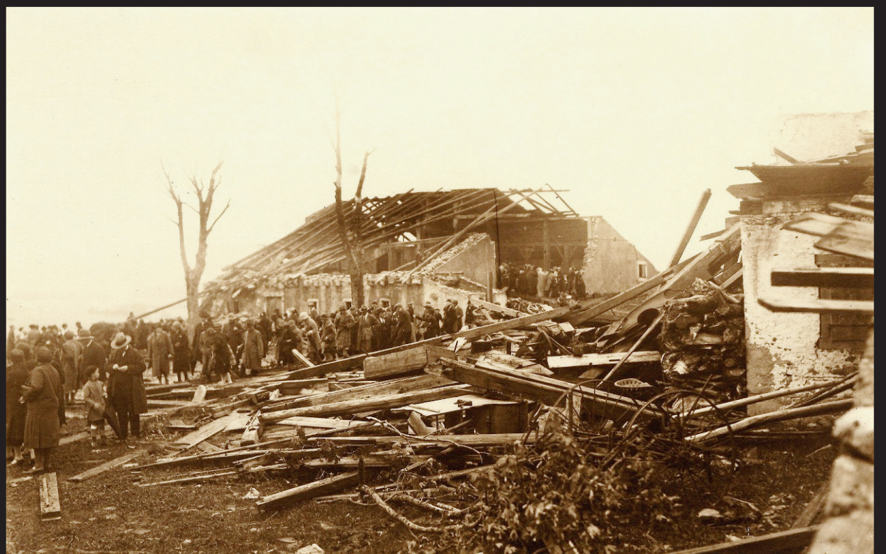
FASCINATION ET COMPASSION 12 juin 1926: en quelques minutes, un cyclone traverse le haut du canton et le Jura, faisant des dégâts considérables. Le spectacle des fermes détruites, des arbres déracinés et des vaches mortes apitoie et fascine. Les journaux y consacrent de nombreux articles, des visites en autocar des «zones ravagées» sont proposées aux curieux, tandis que des cartes postales représentant la catastrophe, comme celle-ci, sont éditées. Le produit de leur vente sert à soutenir les sinistrés. /chr-DAV
