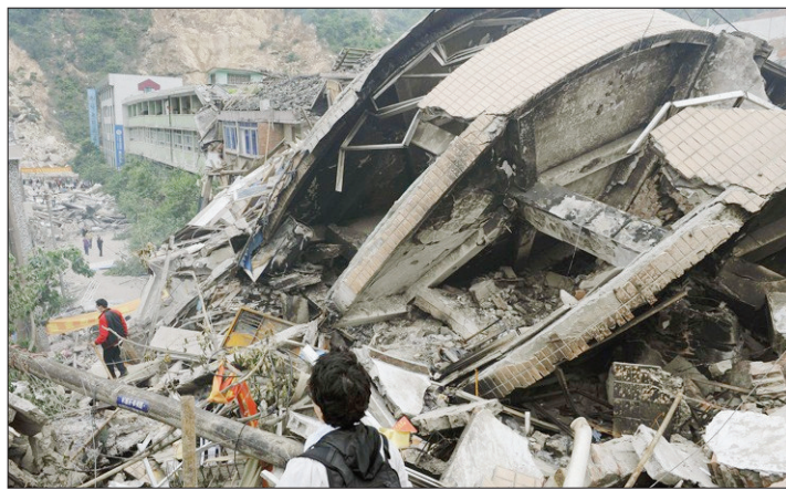
BEICHUAN Un immeuble en béton s'est complètement effondré sur lui-même, ensevelissant ses occupants. (KEYSTONE)
