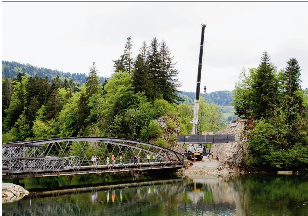
BIAUFOND Hier, la liaison Suisse-France a été fermée à la circulation pour permettre à une grue de 60 tonnes de déposer trois caissons flottants de 12 tonnes chacun qui supporteront le pont provisoire. (GUILLAUME PERRET)
