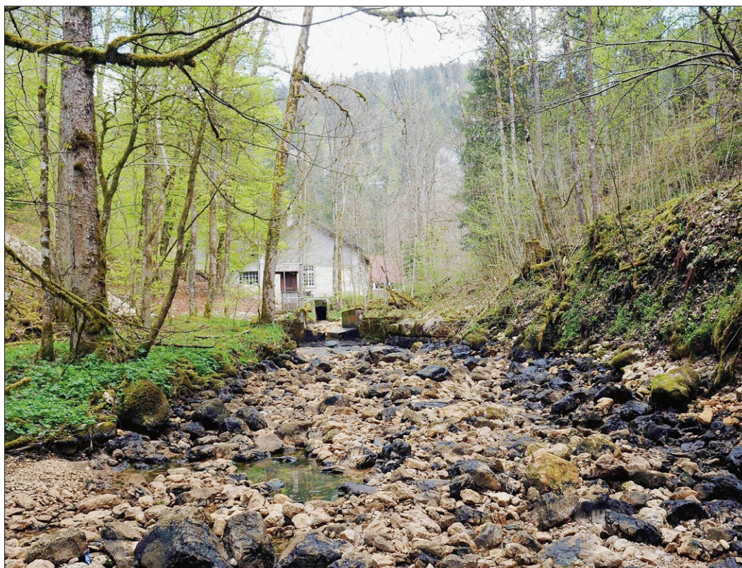
IMAGE TROMPEUSE Les travaux de curage et d'évacuation de matériaux excédentaires de la Rançonnière (à sec, actuellement) ont débuté l'an dernier. Ils reprennent en aval afin d'assurer le bon gabarit hydraulique du ruisseau, qui serpente du Col-des-Roches aux Brenets. (CHRISTIAN GALLEY)
