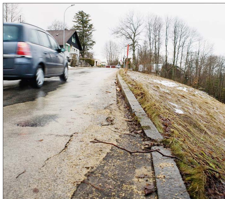
RUE DES FIOTTETS Les travaux débiteront le 15 avril et dureront environ cinq mois et demi. La route sera complètement fermée. (GUILLAUME PERRET)
