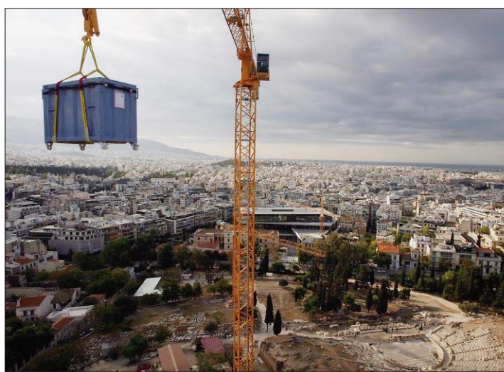
TRANSFERT Une opération de 1,6 million d'euros.
