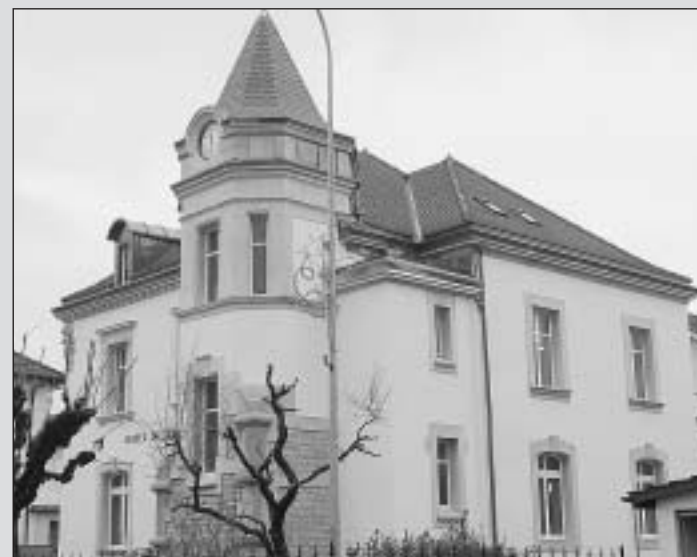
La superbe rénovation de l'Hôtel de ville aura coûté au final 1,63 million de francs. PHOTO ARCH-QUELOZ
