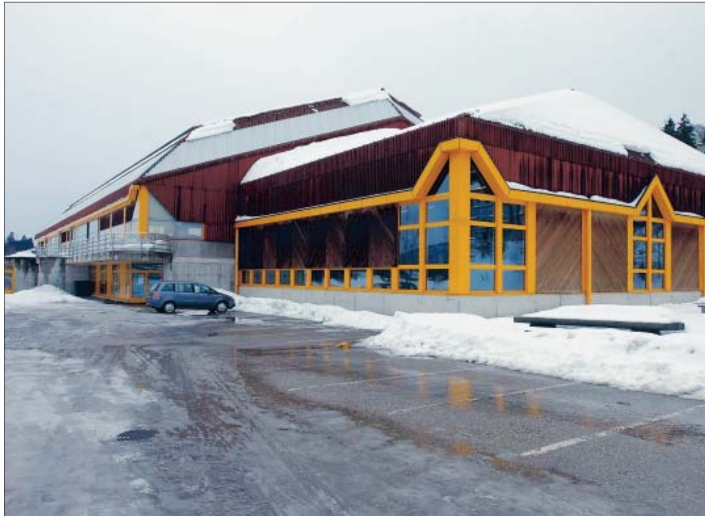
A bout de souffle, la chaudière du centre du Bugnon pose de sérieux problèmes de maintenance. Le projet de chauffage à distance tombe à pic.
