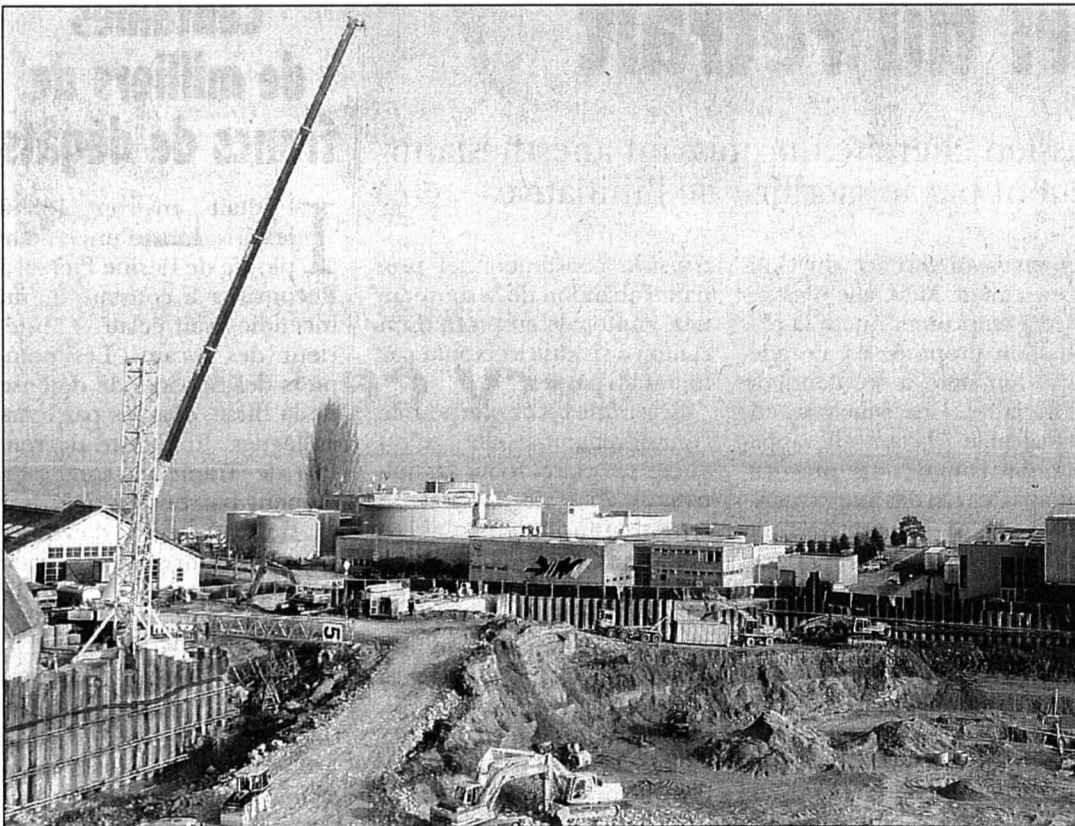
Il a fallu une autogrupe impressionnante par la longueur de son bras pour mettre en place la grande grue.
