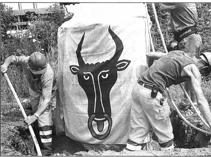
Un rocher de quatre tonnes a été placé à côté du futur portail uranais des NLFA. PHOTO KEYSTONE
