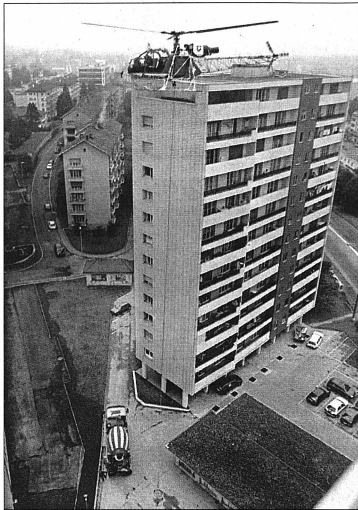
Rue du Locle 44, l'hélicoptère de Heliswiss Gruyères a transporté le matériel nécessaire à la réfection du toit.
