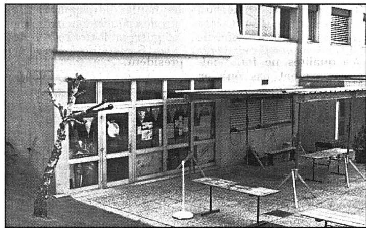
Le centre sportif des Geneveys-sur-Coffrane verra son étanchéité renforcée. photo a
