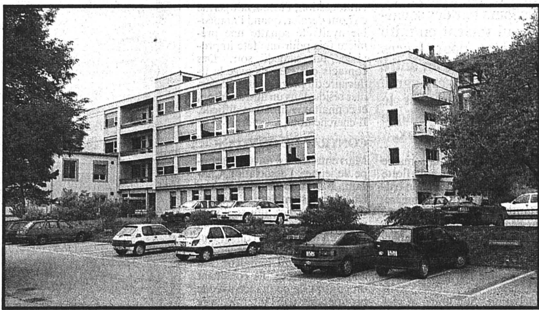
Hôpital de Pourtalès à Neuchâtel
