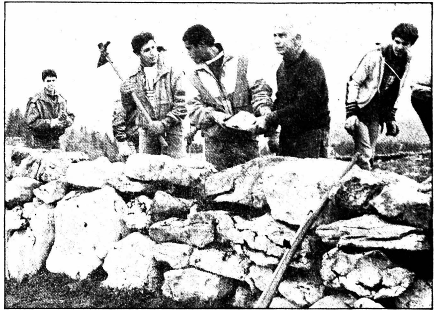
Réfection du mur. Le Dr Béguin dirige le chantier. (Impar-Charrère)
