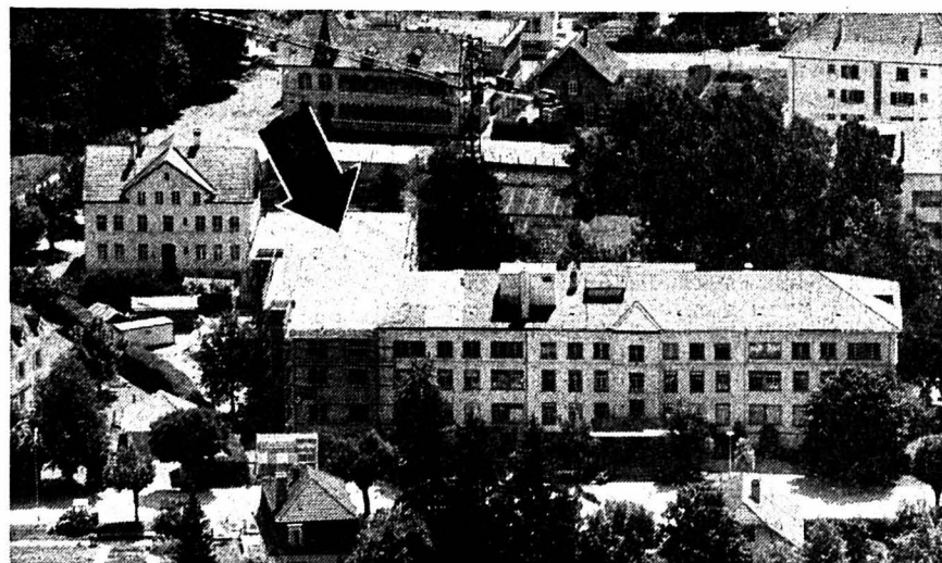
L'Hôpital de Fleurier qui deviendra home médicalisé. L'annexe (flèche) est sous toit. (Impar-Charrère)
