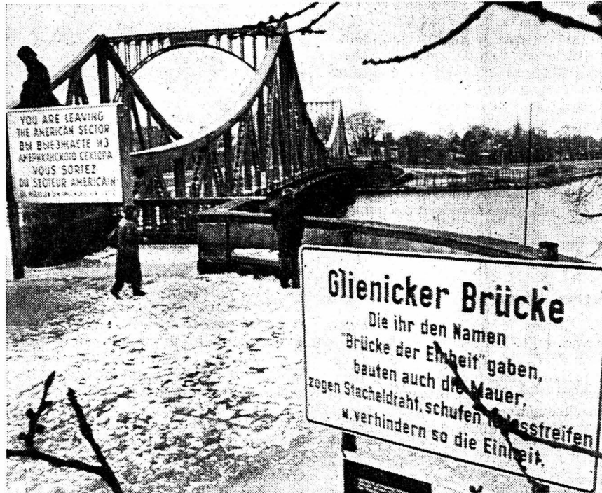
Le pont Glienicker, qui marque la frontière entre l'Allemagne de l'Ouest et Potsdam, à l'Est. Le trait d'union métallique sera prochainement le théâtre d'un troc devenu courant. (Béline APO)
