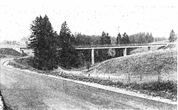
Le pont en béton précontraint d'une longueur de 130 mètres à La Ferrière: 1000 mètres cubes de béton, 120 tonnes d'acier. L'une des belles réalisations destinées à faire correspondre le tracé aux exigences des véhicules et de la vitesse actuels. (photo Impar - Bernard)
