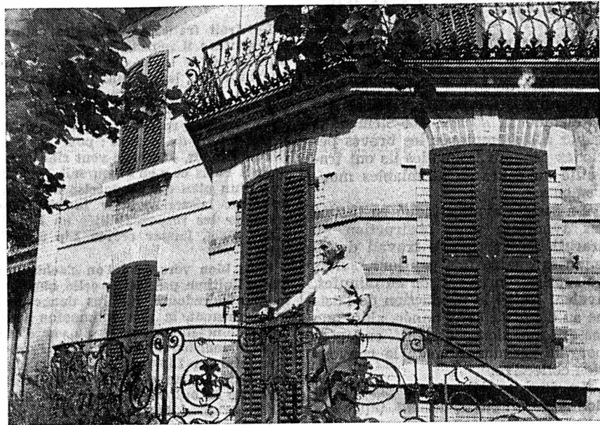
L'immeuble faisant partie du legs. Cet immeuble sera certainement démoli, car il est vétuste. Sur le perron, M. Marcel Paroz, ancien locataire, qui s'occupe actuellement de la surveillance de la propriété. (Photo cg)
