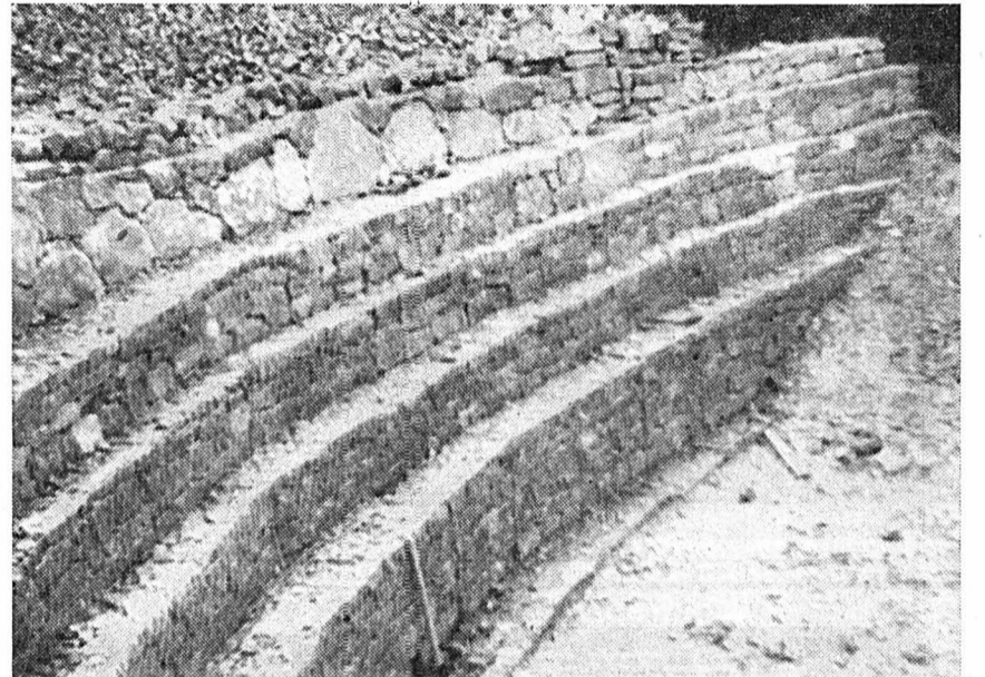
Les gabions, cages de treillis remplis de cailloux, forment la base étagée et solide du grand cône qui soutient la route.
