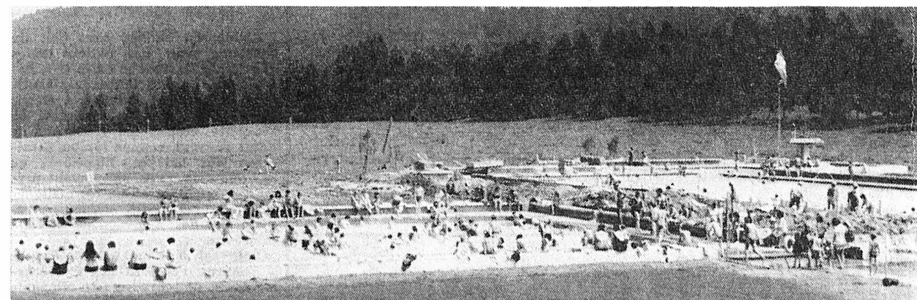
Ouverte il y a environ un mois, la piscine de Tramelan connaît un succès énorme. De toute la région arrivent aussi des amateurs de baignade en eau chauffée et maintenue à une température de quelque 21 degrés. Notre photo montre les installations bien comprises ainsi que les vastes espaces réservés au délassement et au repos. On sait que le grand bassin, avec ses 50 mètres de long, est aux dimensions olympiques. (hi, photo y)
