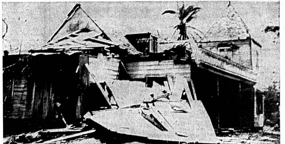
Un cyclone a ravagé l'île Maurice et y a causé de gros dégâts.
