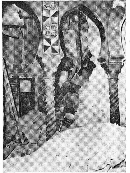
Au cœur même de la Casbah d'Alger, les forces de l'ordre ont découvert la maison qui servait de quartier général aux chefs des rebelles. Solidement fortifiée et défendue avec courage, la maison fut prise d'assaut par les troupes françaises et entièrement détruite.
