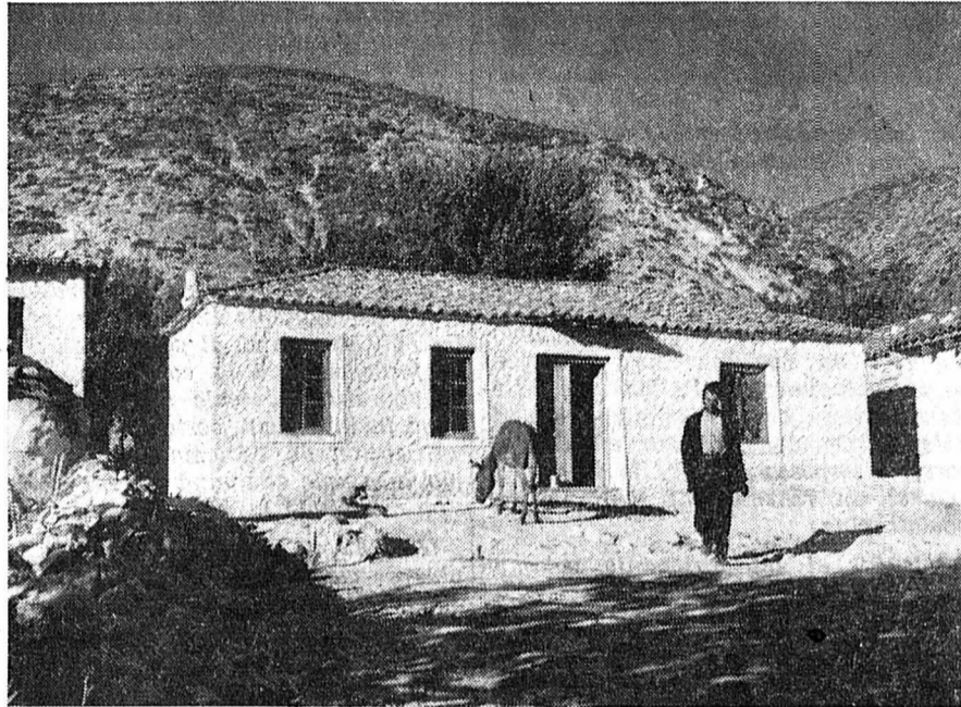
Maison terminée à 1 étage pour petite famille à Lava: deux chambres et un débarras. L'abri utilisé auparavant sert en général d'étable.
