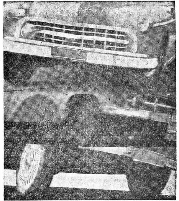
La Frigate 1956 possède une suspension à 4 roues vraiment indépendantes, avec ressorts hélicoïdaux qui ne nécessitent aucun entretien. A l'arrière, l'articulation du triangle de suspension est inclinée de telle sorte que le carrossage des roues varie suivant les débattements. Cette solution d'avenir, réalisée par les ingénieurs des Usines RENAULT, offre d'énormes avantages :
