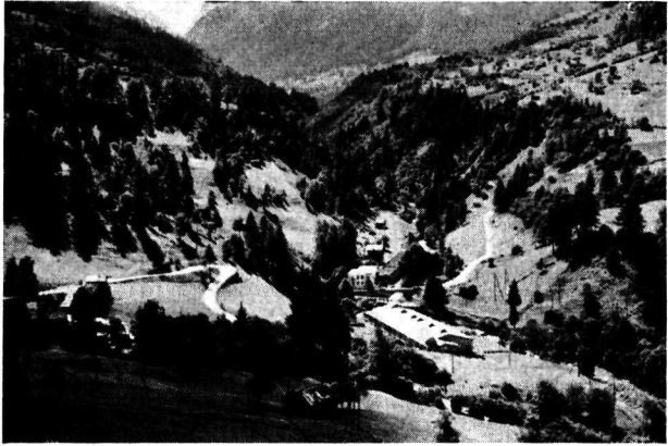
Fig. 6. — Usine actuelle des Services industriels de la commune de Sierre et station actuelle de dessablage du palier Vissoie-Chippis de la S. A. pour l'Industrie de l'Aluminium. Emplacement de la nouvelle usine de Vissoie. (Photo AIAG)
