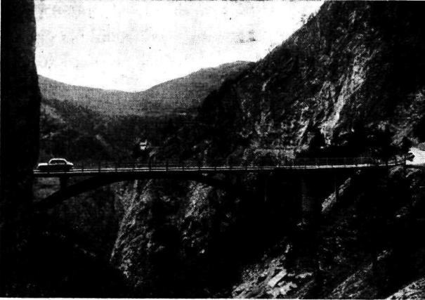
Fig. 8. — Route Sierre-Vissoie. Pont des Pontis (projet A. Sarrasin). Au fond à droite: portail du nouveau tunnel; à gauche de ce dernier: portail de l'ancien tunnel.
