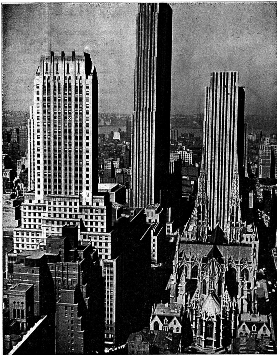
Le bâtiment 444 Madison Avenue à New-York avec les bureaux du Consulat Général Suisse au 35 me étage (X). A droite, la cathédrale St-Patrick, au centre, le gratte-ciel Radio-City, au fond, le fleuve Hudson.
