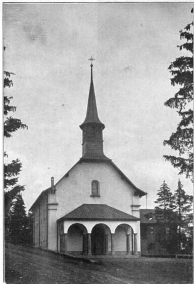
Eglise de Montana-Station
