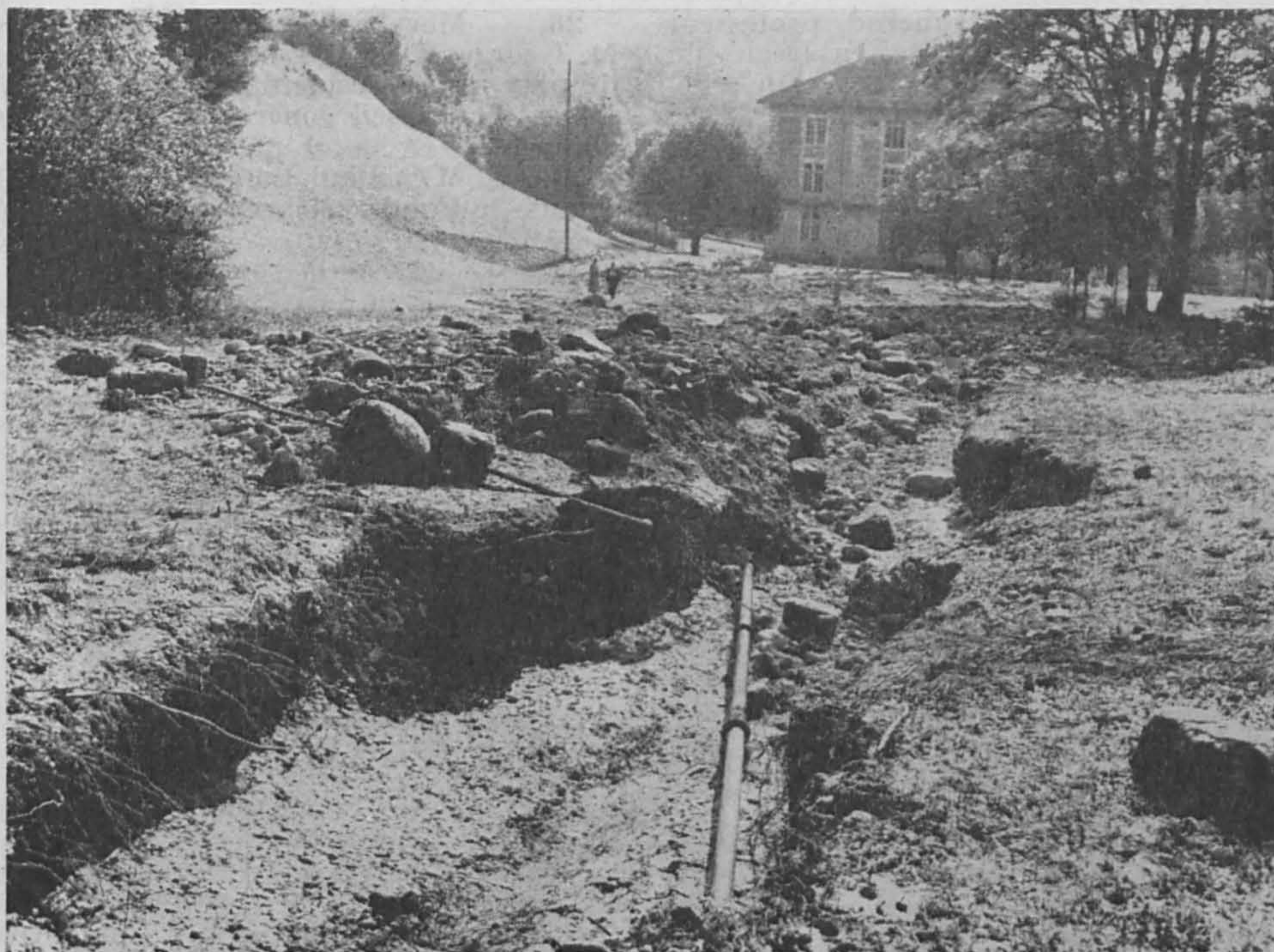
A la suite d'une tornade, un torrent de boue, dévalant de la Pouetta-Combe, a atteint le village de Rochefort, causant d'assez graves dégâts.
